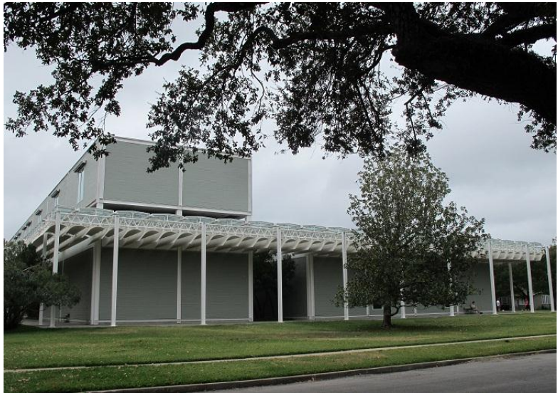
Główny budynek kolekcji Menilów
